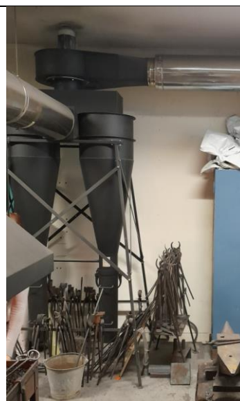
Extraction et filtration de la forge à charbon
