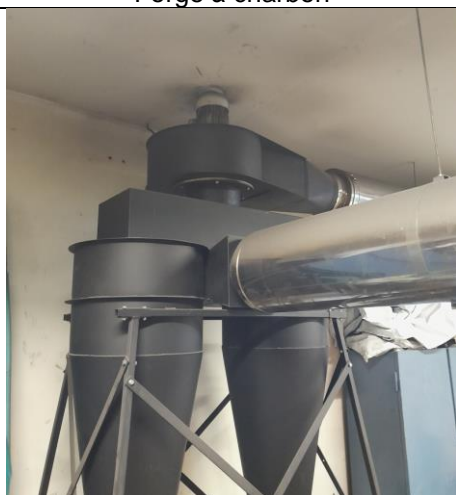
Extraction et filtration de la forge à charbon
